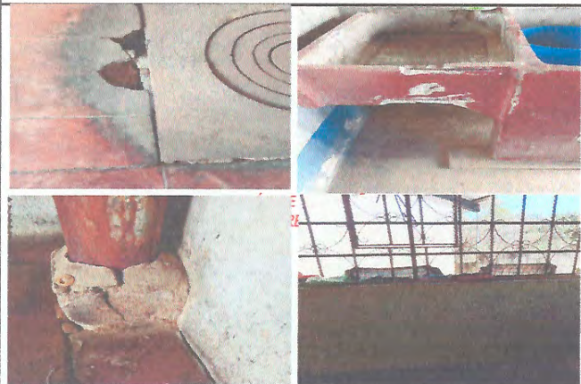
Foto 3: Mejoramiento de área de cocina (sustitución de plancha de metal y chimenea, sustitución de pila de cemento y mejoramiento de ventana para facilitar la distribución de los alimentos a los niños y niñas)
