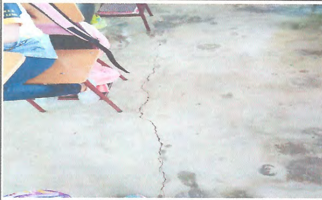
Foto 1: Mejoramiento de piso (instalación de azulejo)
